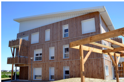
La résidence Hélios - 1 ère réalisation de l'office labellisée E+C-, 36 logements locatifs livrés en mai 2019.
