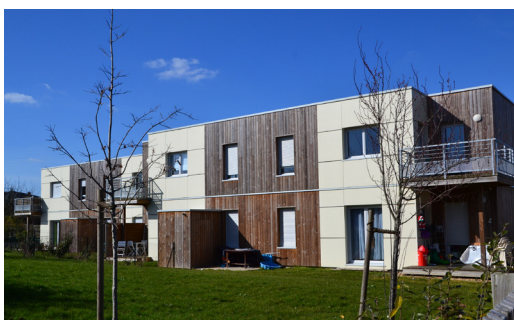
La résidence locative Casteret - 16 logements livrés en juin 2012.
