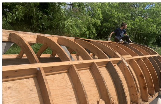
Le démontage de la charpente avant son départ vers sa seconde vie.
